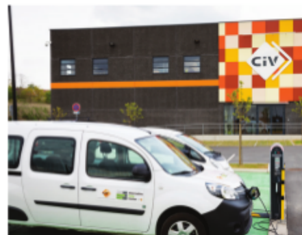
Data Center de la métropole valenciennoise
